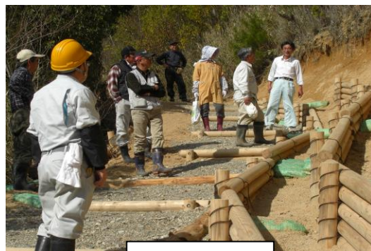
完成した遊歩道
