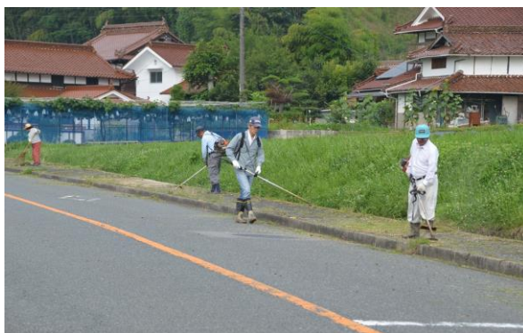
県道小田白市線「歩道」除草
