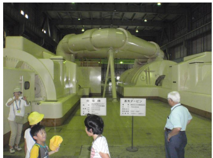
発電機・タービン（建物内45度、熱い熱い）
