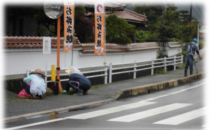
歩道の草刈・清掃作業の様子
