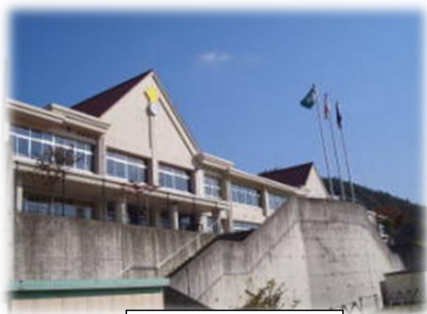
河内西小学校校舎
