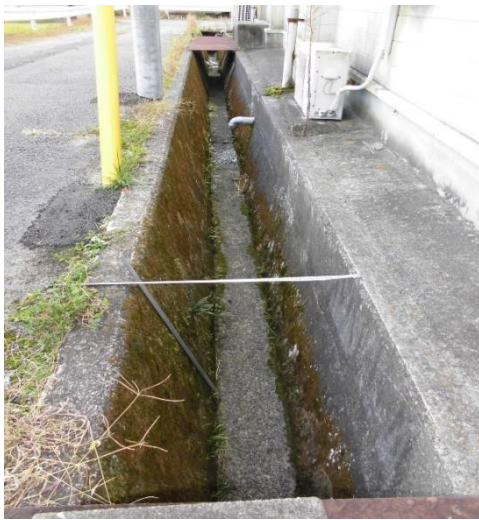
東側水路内転落防止（安全施設設置）巾 90 cm 深さ 90 cm
