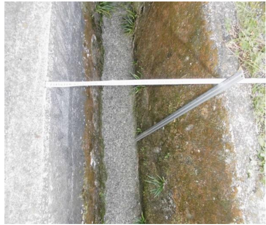
東側水路内転落防止（安全施設設置）巾 90 cm 深さ 90 cm
