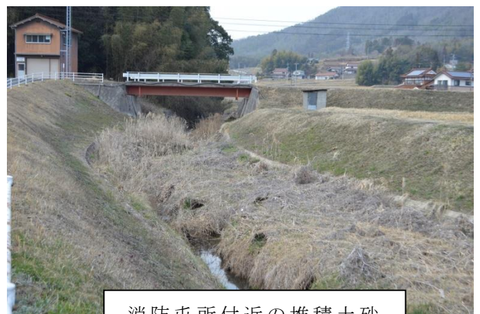
消防屯所付近の堆積土砂
