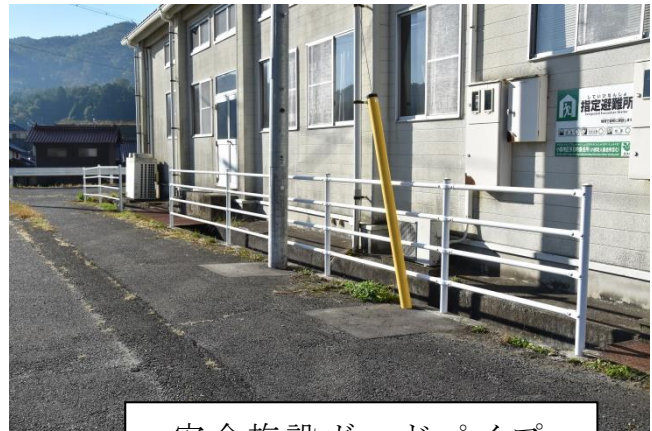
安全施設ガードパイプ
