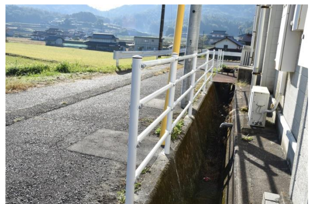
設置後（ガードパイプ）
